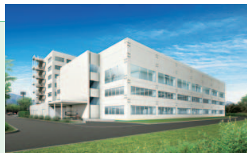
2006年8月竣工予定の新工場
