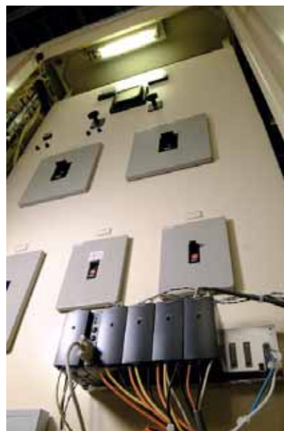
受電盤で電力の計測中
